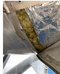
In particolare, le fibre campionate hanno un diametro nettamente superiore rispetto al limite dei 6  $\mu\text{m}$  de questo indica fin dal principio che la fibra non sarà pericolosa. Il diametro medio misurato è infatti di 20-25  $\mu\text{m}$ , indicando che si è in presenza di fibre a filamento continuo.
