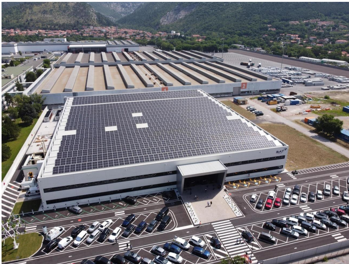
Figure 5: stabilimento oggetto di studio
