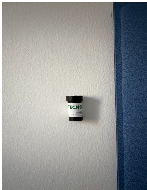
Figura 19 misuratore Tecnorad CR39 installato sulla parete
