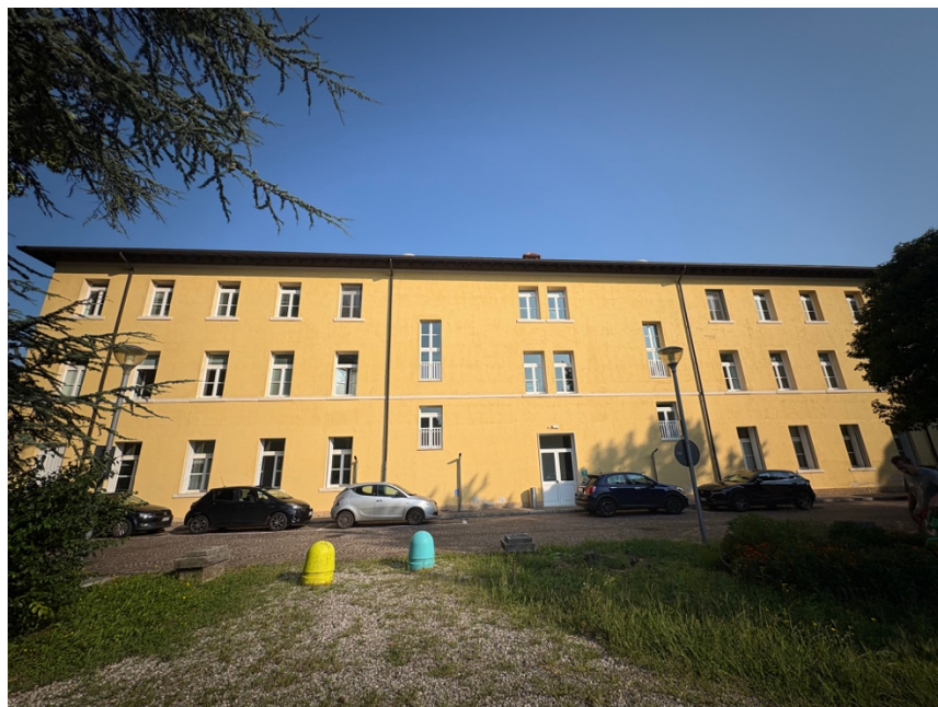
Figura 12: facciata posteriore edificio
