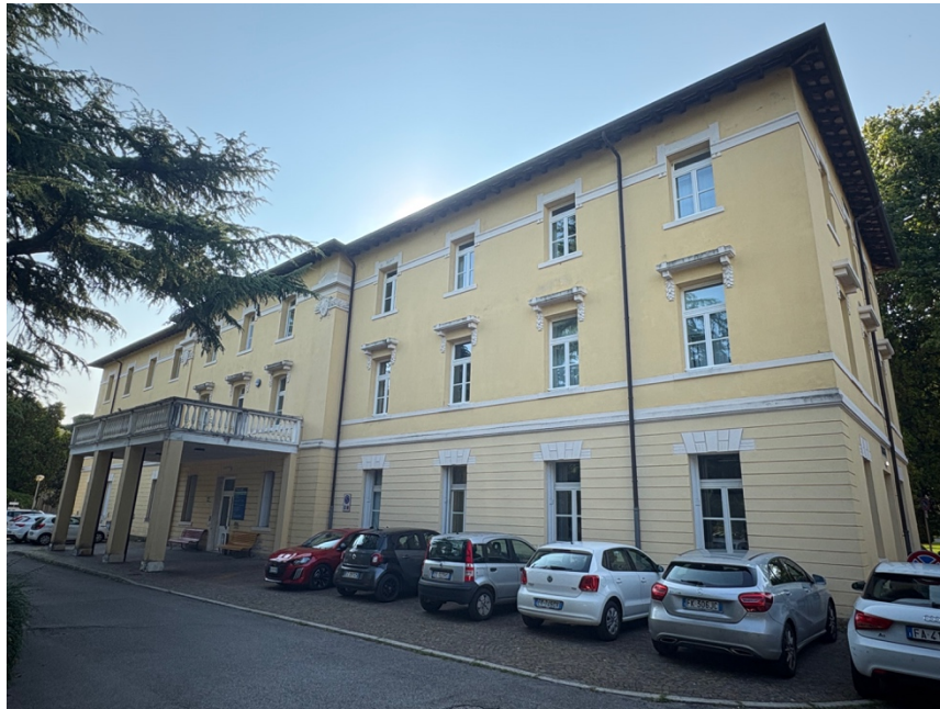
Figura 11: accesso principale edificio
